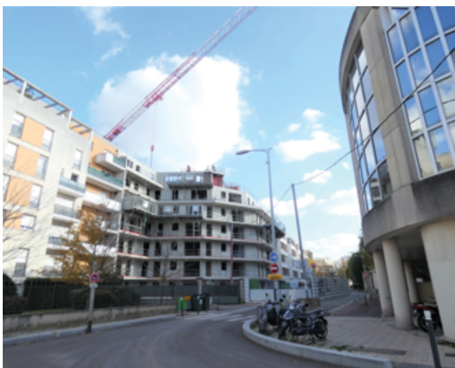
▲▲ Perspective du projet finalisé (photo du haut) et vue du projet en cours de construction
