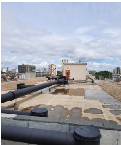
> Dépose du gravier pour réfection
