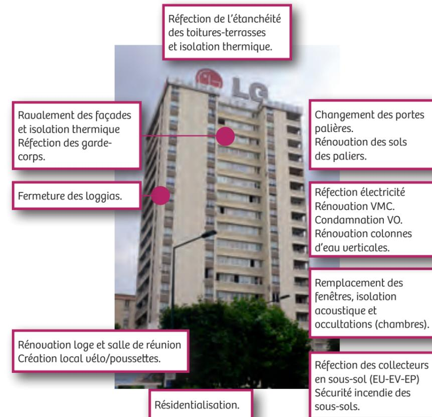
Réfection de l'étanchéité des toitures-terrasses et isolation thermique.
