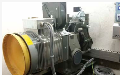
Modernisation 2 ascenseurs 17 rue Jean Mermoz : 54 575 €
