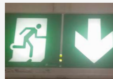
Remplacement de 1716 blocs de secours sur quasiment l'ensemble du parc du patrimoine : 107 710 €
