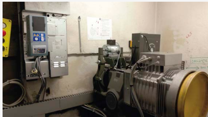
Modernisation 2 ascenseurs 17 rue Jean Mermoz : 54 575 €
