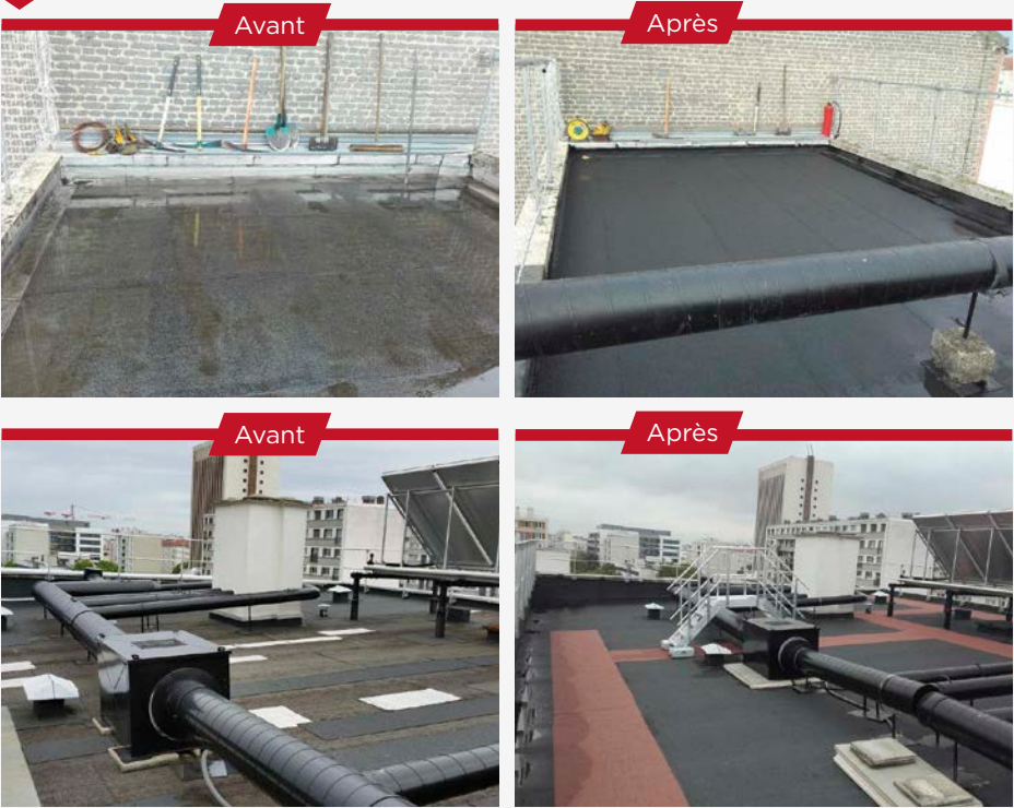
Réfection de la membrane de la Terrasse 210 av. Pierre Brossolette Escalier 1
