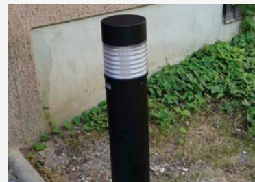
Remplacement de 6 bornes d'éclairage Résidence Thorez : 5 174 €
