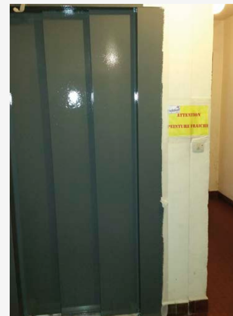
Réfection électrique du local Amicale Résidence des Poètes Réfection électrique du bureau d'accueil 50 rue Guy Moquet Peinture de toutes les portes ascenseurs Résidence Salagnac
