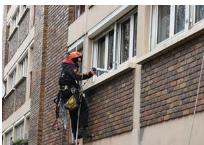
> Résidence L. Salagnac : réfection des joints d'étanchéité extérieurs
