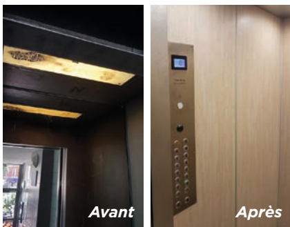
> Rue de la Tour : habillage de la cage d'ascenseur
