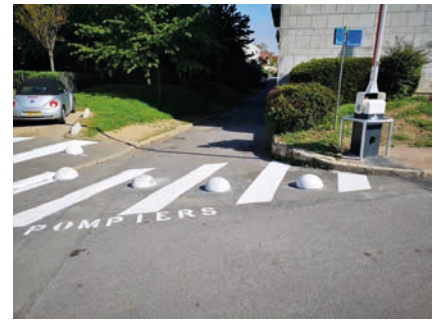
> Résidence Les Poètes : installation des barrières levantes
