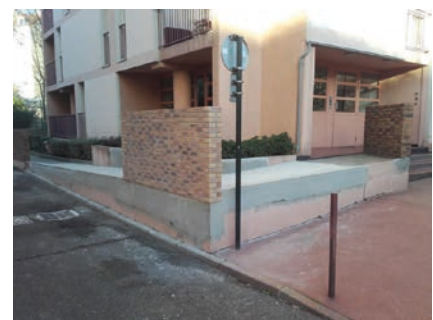
> 6 rue Henri-Martin : création d'une rampe pour personne à mobilité réduite
