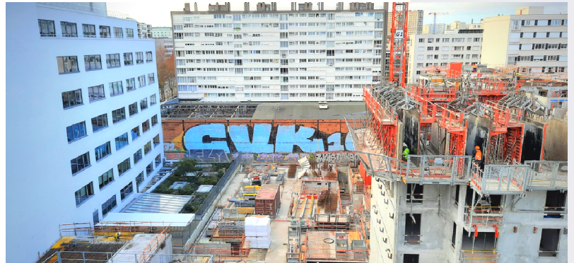
Chantier en cours
