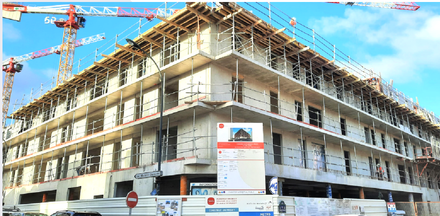
Chantier en cours
