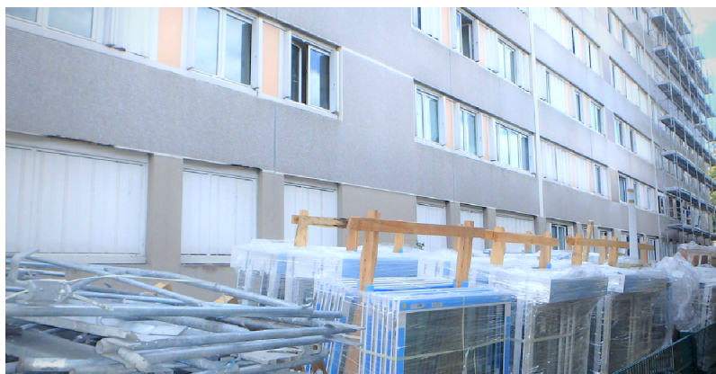
Installation des nouvelles fenêtres
